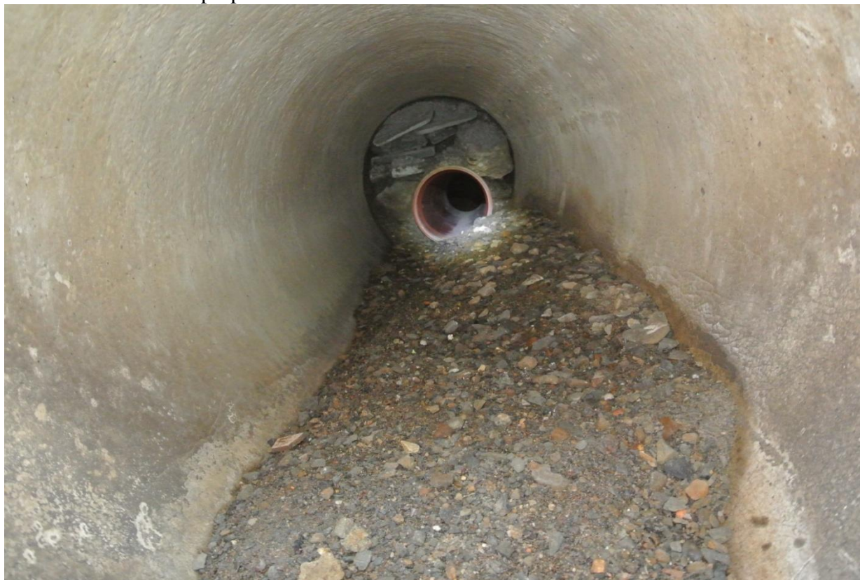
Železniční propustek – zanesená vtoková strana
